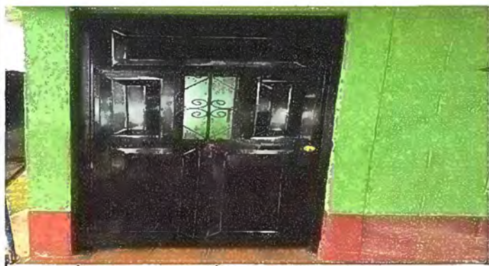
Foto 5: MÓDULO I. SUSTITUCIÓN DE PUERTA DE METAL
