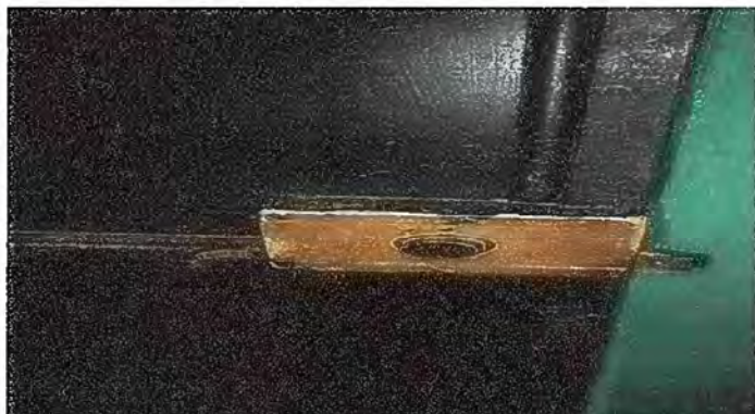
Foto 4: MÓDULO I. SUSTITUCIÓN DE CHAPA
