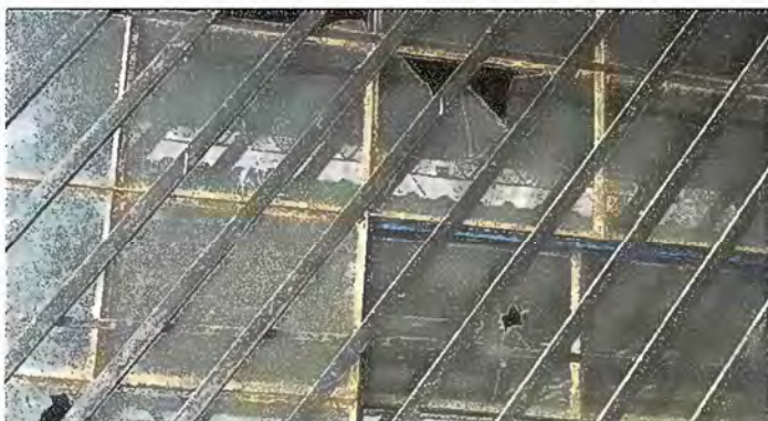
Foto 3: MÓDULO I. SUSTITUCIÓN DE VIDRIOS
