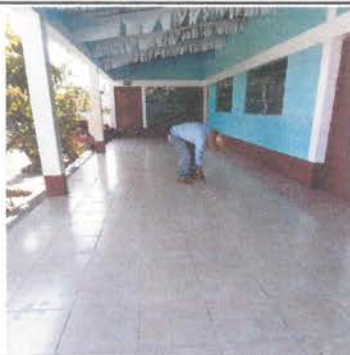
Foto 3: Sustitucion de piso de torta de concreto
