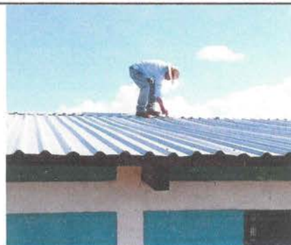
Foto 2: Sustitución de laminas por lamina troquelada Aluzinc
