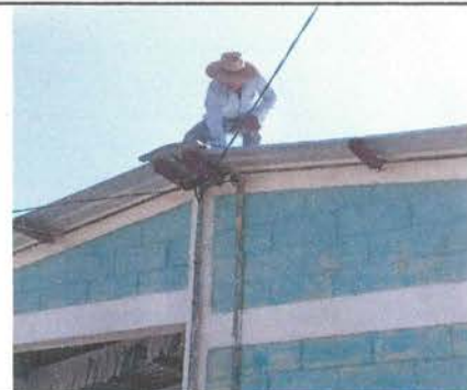
Foto 4: Sustitución de capote de lamina por lamina troquelada
