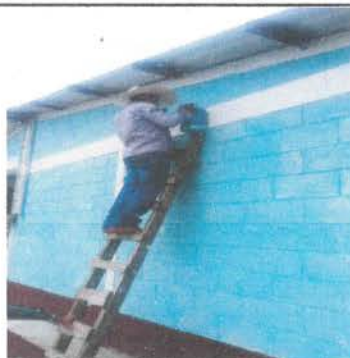
Foto1: Limpieza y pintado de pared
