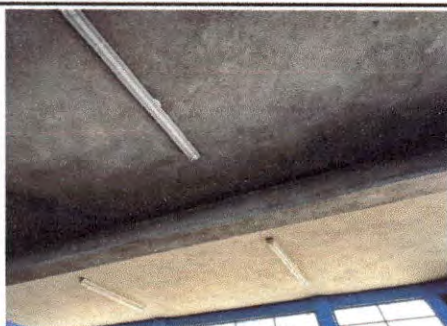
Foto 3: AULAS EN MUY BUEN ESTADO PERO SIN PINTURA EN AREA DE TECHOS (LOSA).
