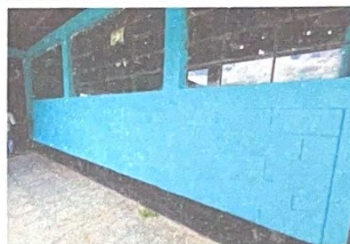
Foto 4: APLICACIÓN DE PINTURA EXTERIOR EN MODULO
