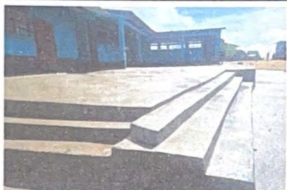
Foto 3: FUNDICION DE RAMPA Y GRADAS EN AREA CENTRAL DE LA ESCUELA
