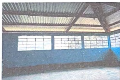
Foto 5: INSTALACION DE TECHO DE LAMINA EN AULA
