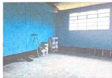
Foto 6: APLICACIÓN DE PINTURA INTERIOR EN AULAS
