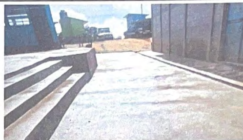
Foto 2: FUNDICION DE TORTA DE CONCRETO EN AREA DE INGRESO
