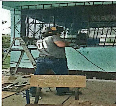
Foto 2: Modulo 2 Sustitucion de vidrios e instalación de balcones.
