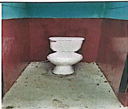
Foto 5: Modulo 3 Sustitución de inodoro y pila.
