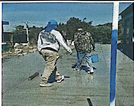
Foto 3: Patio Reparación de patio de concreto.
