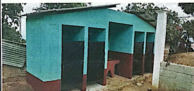
Foto 4. Modulo 3 Fabricación e instalación de puertas de metal.
