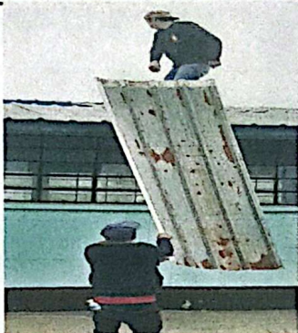
Foto 1: Modulo 1 Cambio de láminas y mantenimiento de costaneras.
