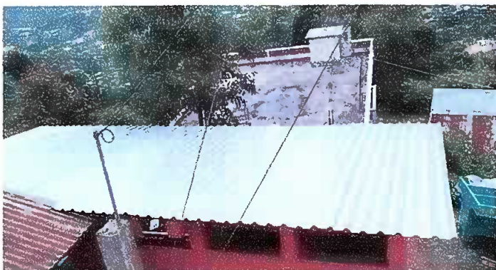
Foto 3: Módulo 2: Sustitución de lamina, por lamina troquelada aluzinc calibre 26.
