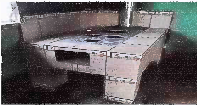
Foto 7 Módulo 4: Sustitución de estufa rural completa chimenea.
