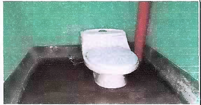
Foto 8 Módulo 5: Sustitución de inodoro
