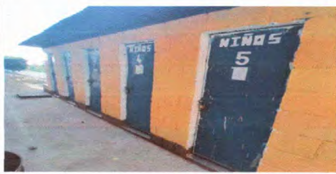
Foto 2 Modulo 1 : mantenimiento a estructura de puerta lijado, cepillado, sujeciones y aplicación de pintura
