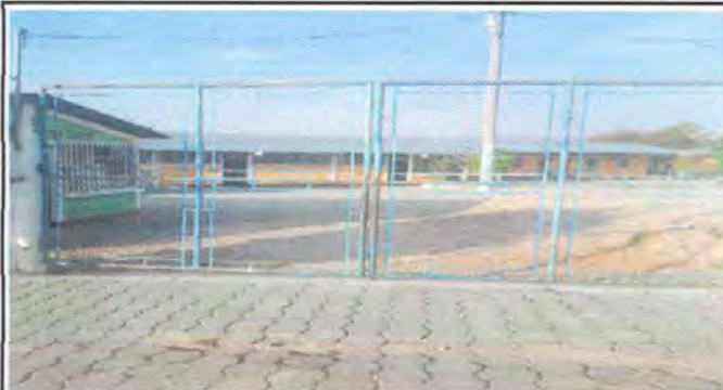
Foto 14 Módulo 7: Mantenimiento a porton de Metal.
