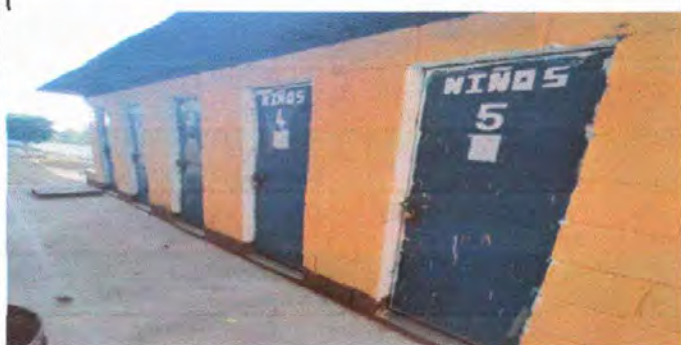
Foto 1 Módulo 1: Sustrucción de estructura de soporte de madera por metal
