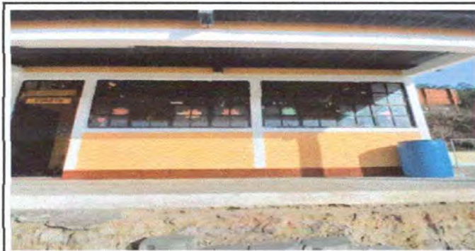
Foto 11 Módulo 6: Sustrucción e instalación de balcon de hierro en ventana y Sustitución de barandas de metal.
