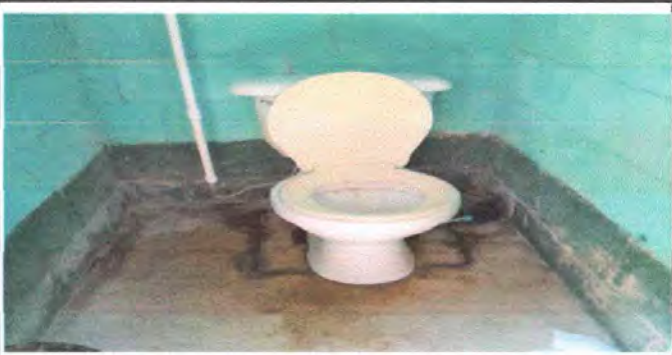
Foto 10 Módulo 5: Sustitución inodoro
