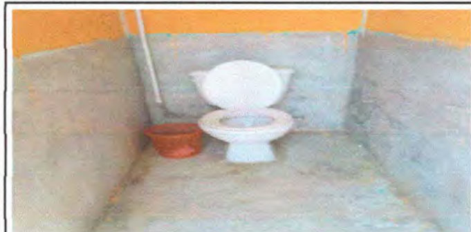
Foto 5 Módulo 1: Sustrucción inodoro
