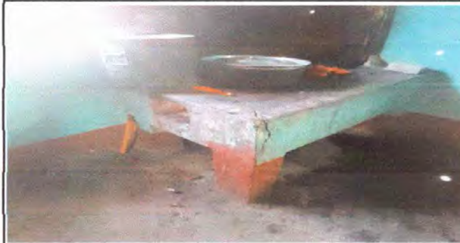
Foto 9 Módulo 4: Sustrucción de estufa rural (completa) chimenea de concreto.
