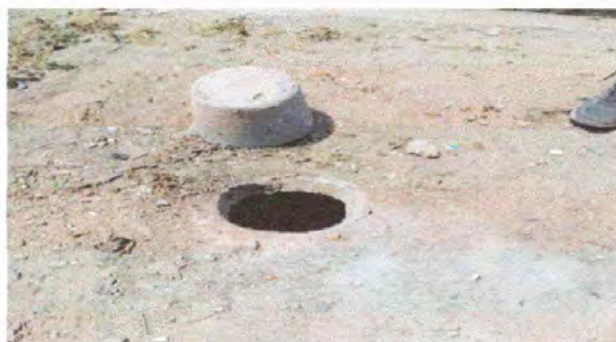
Foto 4 Módulo1 : Reparación de tapaderas de cajas
