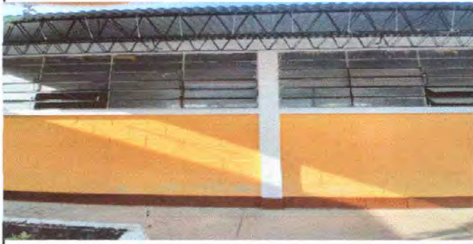
Foto 7 Módulo 2: Sustrucción en suministro de balcones de metal.
