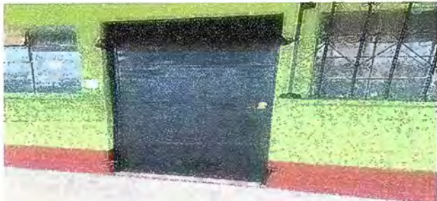
Foto7: Modulo 3 Sustitucion de puerta
