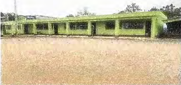
Foto 9, Pintura general Pintura de muros exteriores
