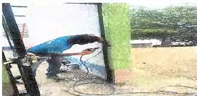
Foto 5: Modulo 1 Sustitucion de puertas
