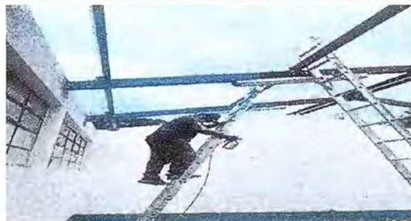
Foto 2: Modulo 1 Sustitucion de cableado, Sustitucion de focos ahorradores , sustitucion de plafoneras y mantenimiento de costaneras
