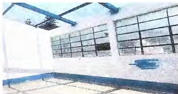
Foto 4: Modulo 1 Sustitucion de vidrios
