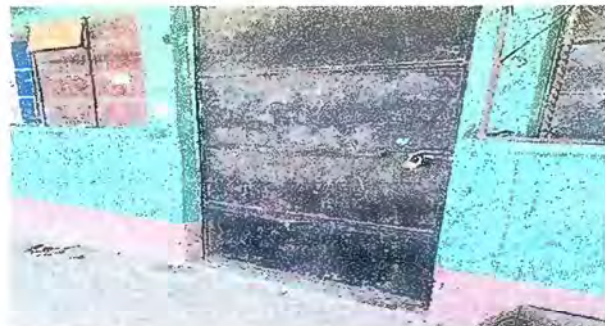
Foto 7: Modulo 3 Sustitucion de puerta
