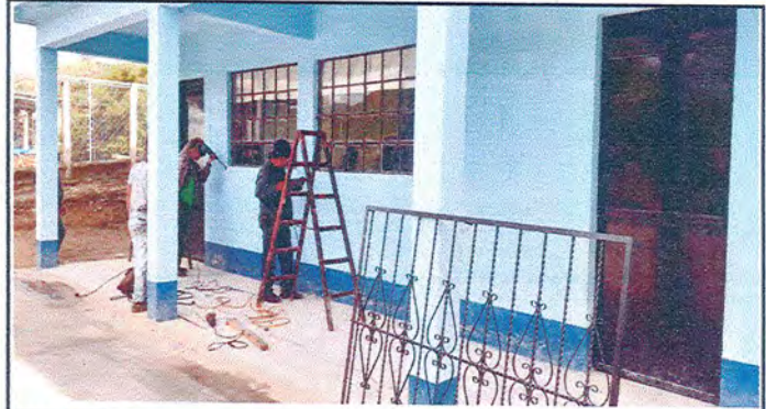
Módulo 1: Suministro e instalación de balcones
