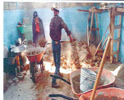
Módulo 2: sustitución de piso de torta de concreto por piso de granito
