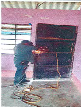
Módulo 1: sustitución de chapa
