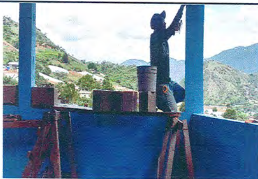
Módulo 2: Reparación de muro de block
