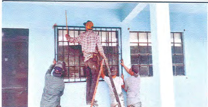
Módulo 3: Sustitución e instalación de balcones
