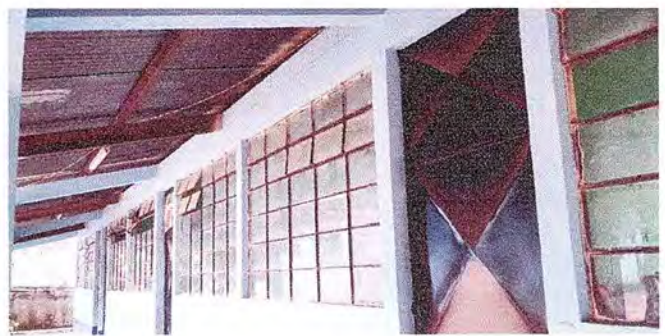
Módulo 1: Suministro e instalación de balcones
