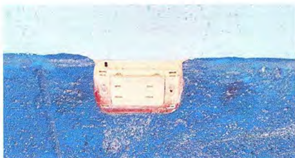
Módulo 1: sustitucion de accesorios de tomacorriente
