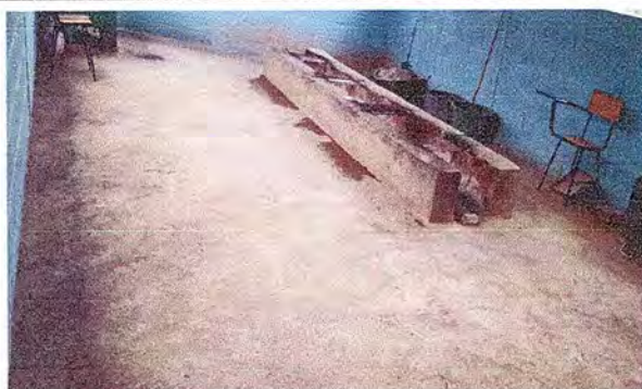
Módulo 2: sustitución de piso de torta de concreto por piso de granito
