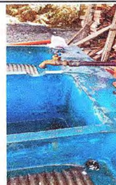
Módulo 2: Sustitucion de llave de choro
