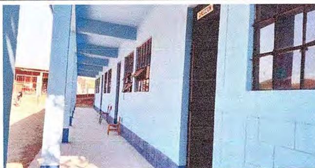
Módulo 3: suministro e instalacion de balcones de 1.25m x 2 m
