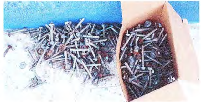
Módulo 1: Sustitución de elementos de fijación ( tornillos)
