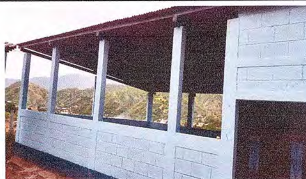
Módulo 2: reparacion de muro de block
