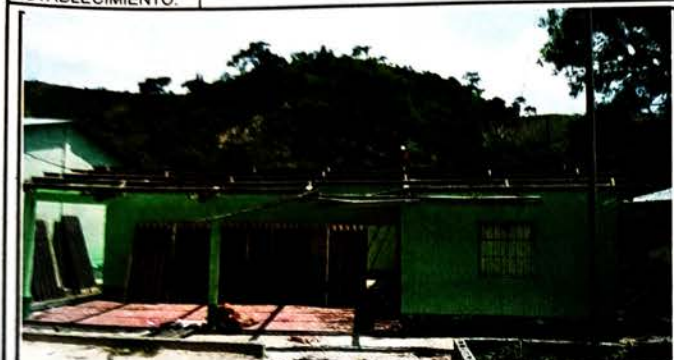
Foto 1 Módulo 1: Sustrución de lamina de duralita por lámina troquelada, costanera y canaletas fluviales
