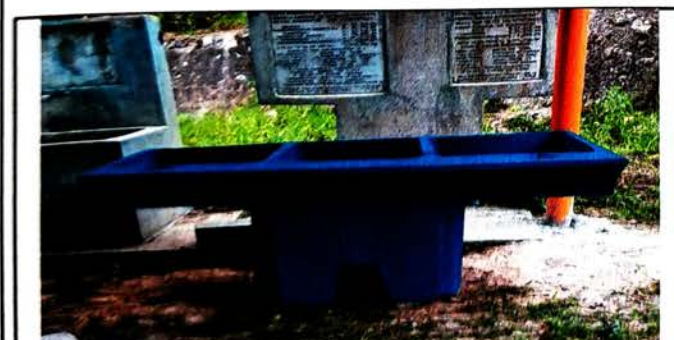
Foto 5 Módulo 1: Sustrución de un lavamano por una pila de dos lavaderos
