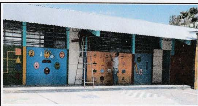
Foto 5: instalación de energia electrica
