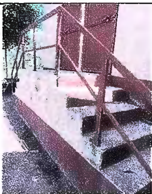
Foto 7: Módulo 1. Mantenimiento a baranda
