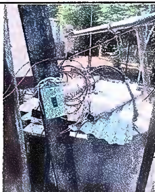
Foto 23: Pozo Artesanal. Instalacion de nueva bomba sumergible para abastecer agua para los sanitarios y agua para los alimentos
