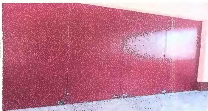
Foto 5: Modulo 2.Mantenimiento a porton de metal
