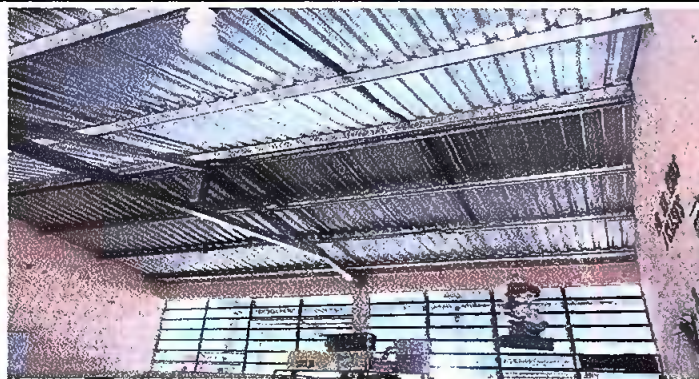
Foto 18. Modulo 3. Instalación lámina troquelada aluzinc calibre 26
