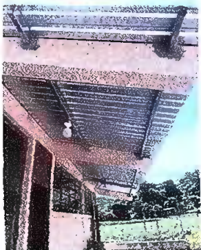
Foto1: Modulo 3. Sustitución de lámina, por lámina troquelada aluzinc calibre 26
