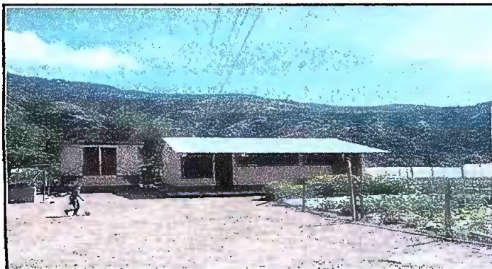
Foto 2: Modulo 3. Instalación de lámina troquelada aluzinc
