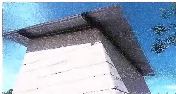
Foto 6: Modulo 1. Instalación de lámina troquelada aluzinc calibre 26
