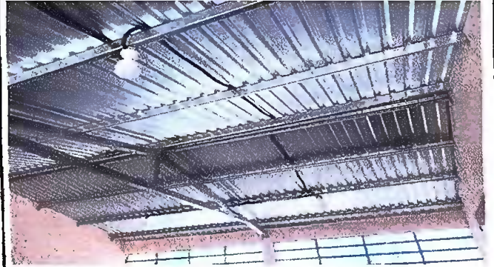
Foto 30 : Modulo 3 Cambio de material portante por costaneras
