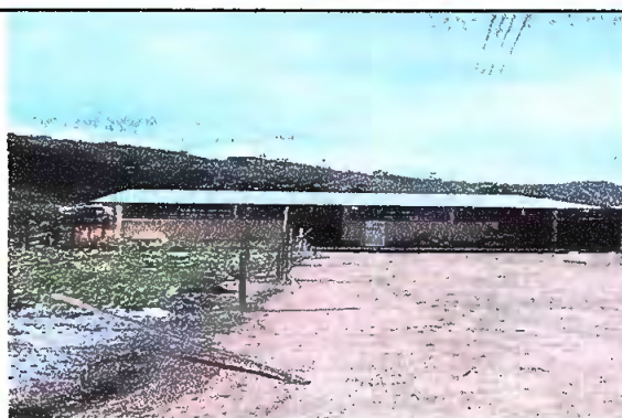
Foto 21. Modulo 2. Vista frontal de la instalación de la lámina troquelada aluzinc calibre 26
