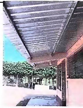
Foto 17: Modulo 3. Instalación de estructura portante de metal
