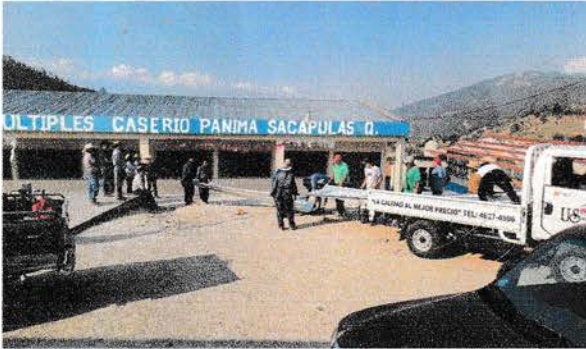
Foto 1: Llegado de materiales de remozamiento.
