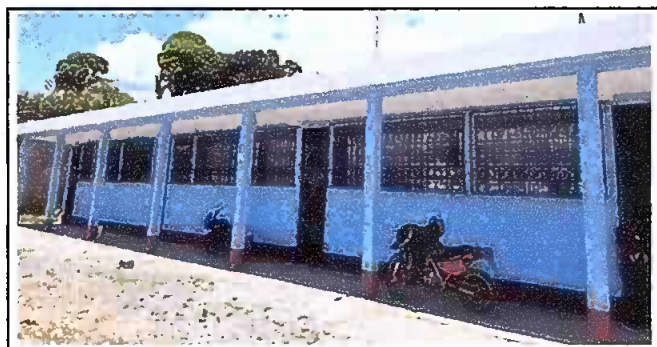
Foto 5: Pinturas en muros exteriores
