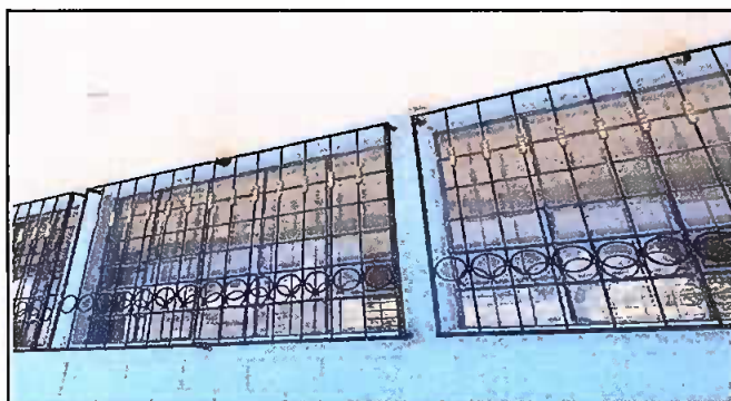
Foto 3: Suministro e instalación de balcones
