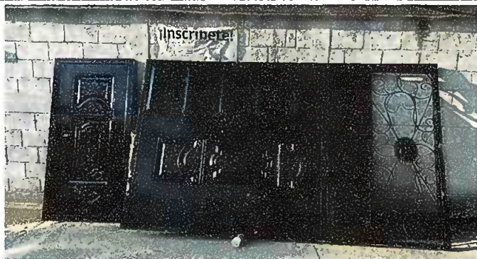
Foto 1: Muro Perimetral sustitución de portón de metal de ingreso.
