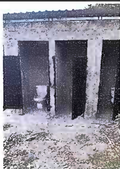
Foto 5: Sanitarios se encuentran en buenas condiciones y funcionando.
