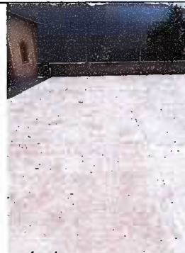
Foto 2: Finalización del pavimento en el patio del establecimiento.
