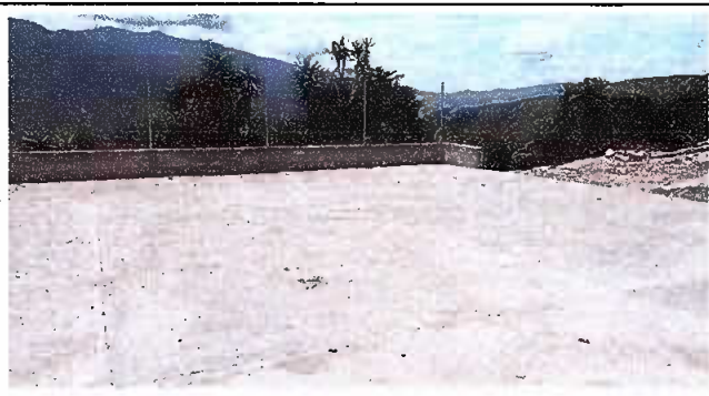
Foto 1: Era una necesidad terminar el pavimento del corredor del establecimiento, evitando así accidentes para los estudiantes.
