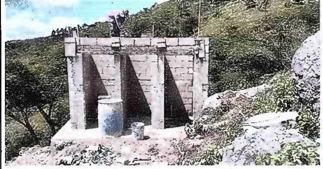
Foto 2: Los sanitarios en proceso de construcción
