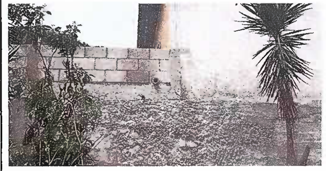
Foto 4: Muro de contención durante la fase intermedia.
