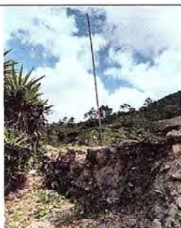
Foto 5: Muro de contención, necesita reparación
