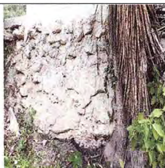
Foto 5: Muro de contención, necesita reparación
