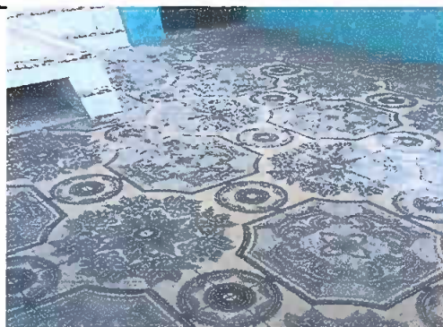
Foto 6: Sustitución de piso de torta de concreto por piso cerámico
