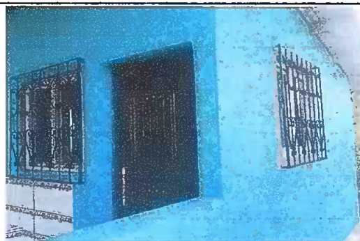
Foto 4: Modulo 1: Apertura de ventana y tallado con balcón
