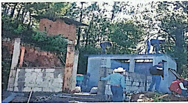
Foto 3: reparacion de muro
