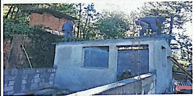
Foto 4: sustitucion de estructura metalica
