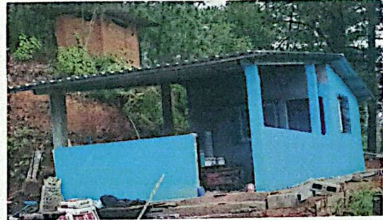
Foto 2: instalacion de lamina
