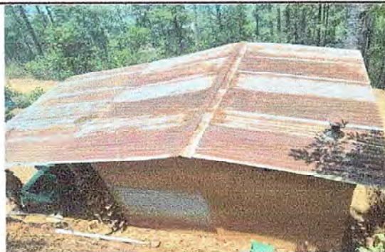
Foto 2: Modulo 1: Sustitución de capote de lamina troquelada
