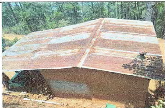
Foto 1: Modulo 1: Sustitución de lamina troquelada
