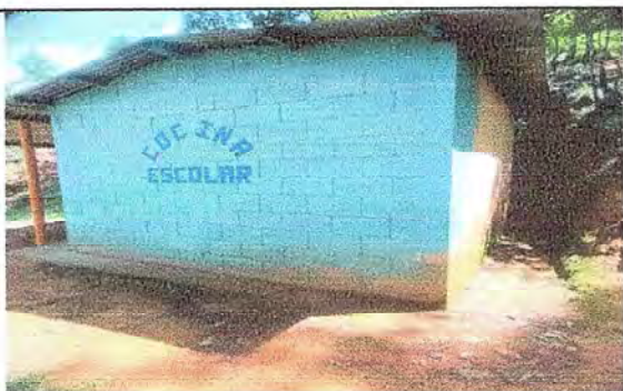
Foto 3: Modulo 1: Sustitución de estructura de metal
