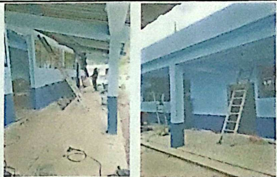
Foto 2: Modulo 1 y 2: Durante la instalación de balcones en ambos modulos.
