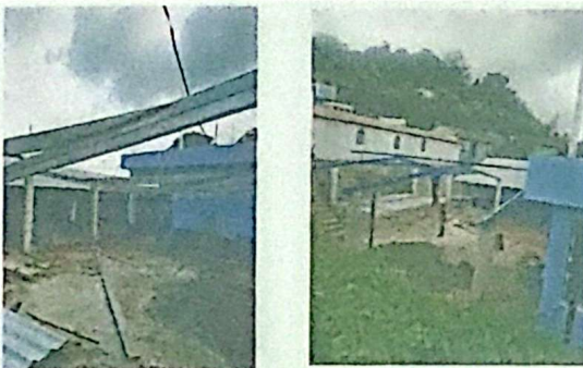
Foto 5: Modulo 5: Durante la instalación del techado.
