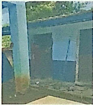
Foto 3: Modulo 3: Durante el proceso de la instalacion y repación de las puertas de los sanitarios.
