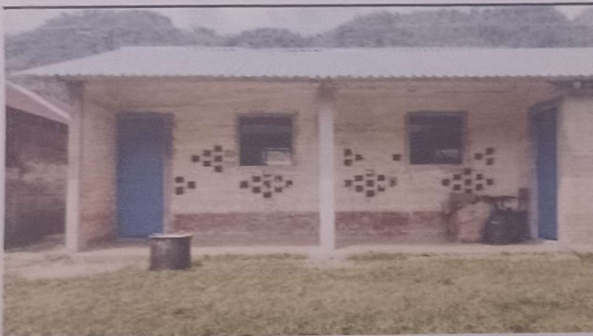
Foto 3: Sustitución de puerta de madera por metal
