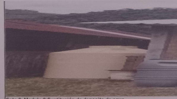
Foto 6: Modulo 2: Sustitución de deposito de agua.
