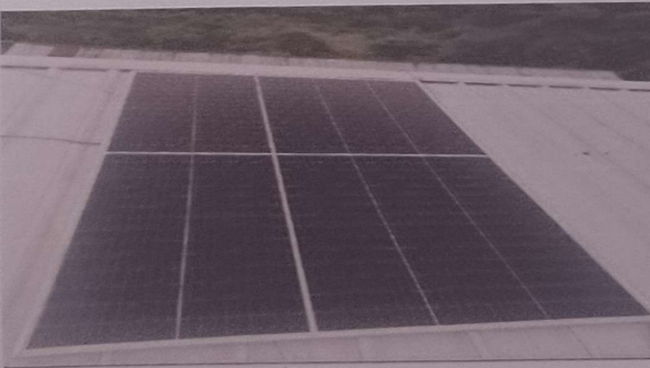
Foto 5: Instalación de panel solar
