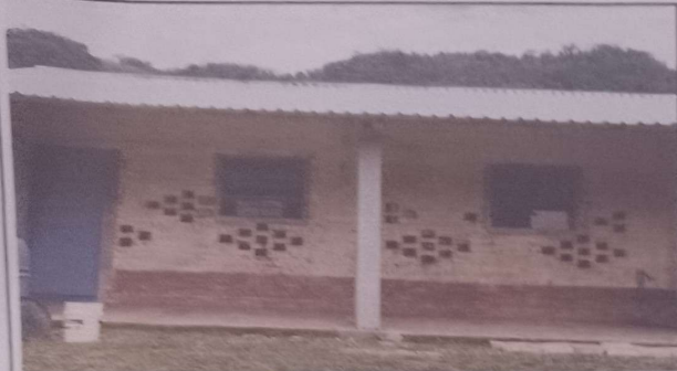
Foto 1: Modilo 1: Sustitución de lamina por lamina troquelada aluzinc calibre 26
