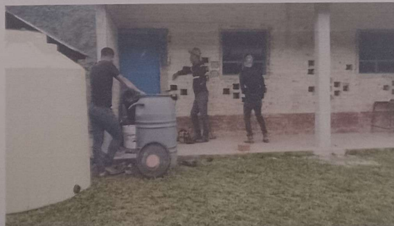
Foto 6: Modulo 2: Sustitución de deposito de agua.
