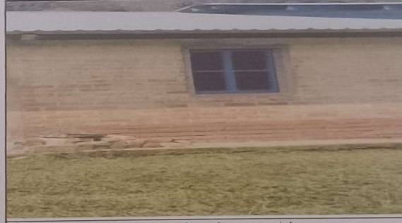
Foto 4: Sustitución de ventanas de madera por metal
