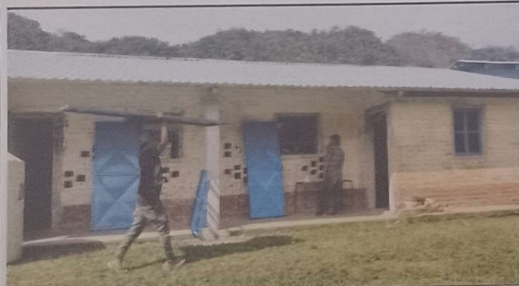
Foto 3: Sustitución de puerta de madera por metal
