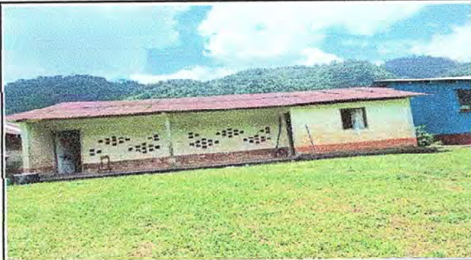
MODULO 1. Foto 1 AULA. Sstitucion de laminas esta en mal estado, sistitucion de tijera y costaneras de madera a metal
