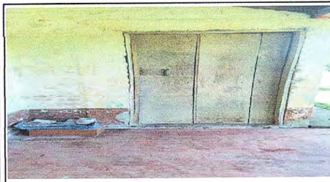
MUDULO 1. foto 3 Sustitucion de puerta de madera a metal
