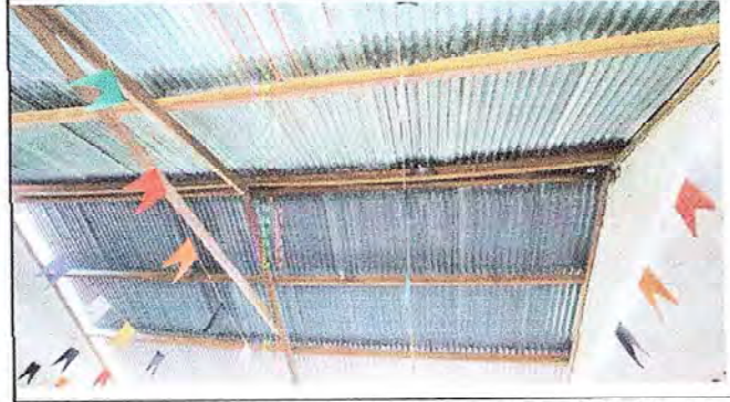
MODULO 1. foto 2 Sustitucion de estructura de soporte de madera por metal
