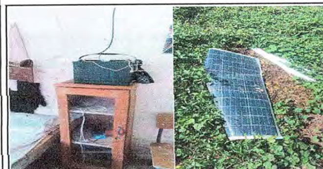
MODULO 1. foto 5 Sustitcion de panel de solar
