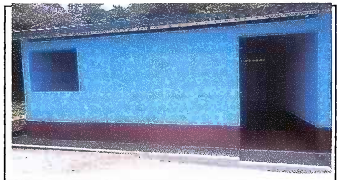
Fotografía No 4 Cambio de pared de madera por block
