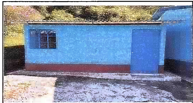
Fotografía No 3 sustitución de puerta
