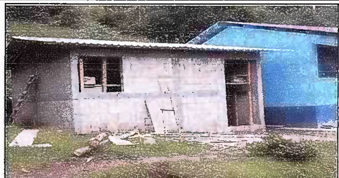
Fotografía No 2 Cambio de techo por lamina Troquelada
