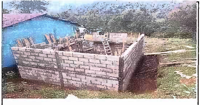
Fotografía No 5 seguimiento de la pared a un 70%
