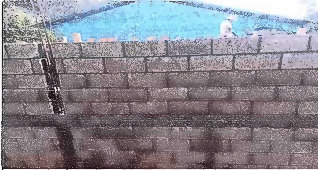
Fotografía No 1 Cambio de pared de madera por Block
