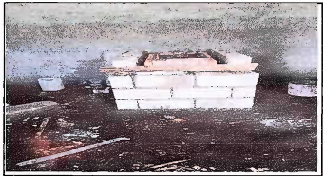
Fotografía No 4 sustitución de Canales. (polieton con hornilla y azulejo)
