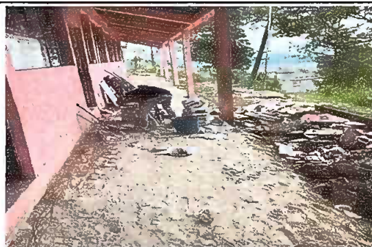
Foto 6: Reparación de piso de cemento líquido de corredor.
