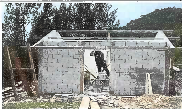
Foto 3: Reparación de muro de block de la cocina.
