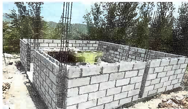
Foto 2: Reparación de muro de block.
