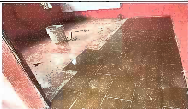
Foto 5: Sustitución de piso cerámico en aulas.
