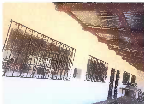
Fotografía No. 4: Fabricación e instalación de balcon de hierro en ventana
