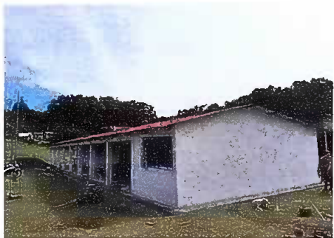
Foto No. 1: Módulo I. Repello en muro (interiores y exteriores)
