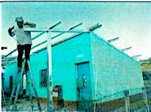
Foto 5: Situación colocando la estructura nueva edificio uno parte alta.
