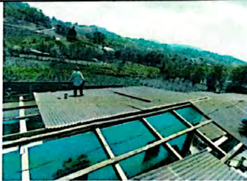
Foto 3: Situación desentechando edificio uno parte alta.
