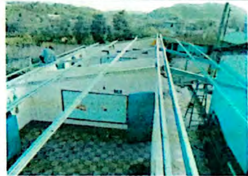
Foto 4: Situación de colocación de costaneras edificio uno parte alta.
