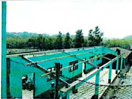
Foto 3: Situación de colocación de costaneras edificio dos parte baja.
