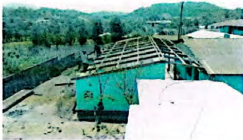
Foto 1: Situación techo remosando edificio uno parte alta.
