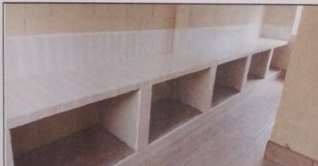
FOTO 6: INSTALACIÓN DE MESA EN COCINA
