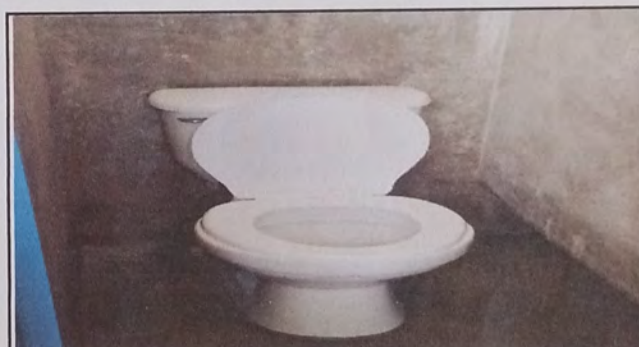
FOTO 10: SUSTITUCIÓN DE INODORO Y ACCESORIOS
