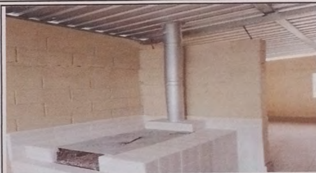
FOTO 2: SUSTITUCIÓN DE CHIMENENA DE METAL UNIDAD
