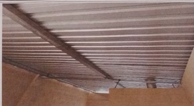
FOTO 1: SUSTITUCIÓN DE LAMINA POR LAMINA
