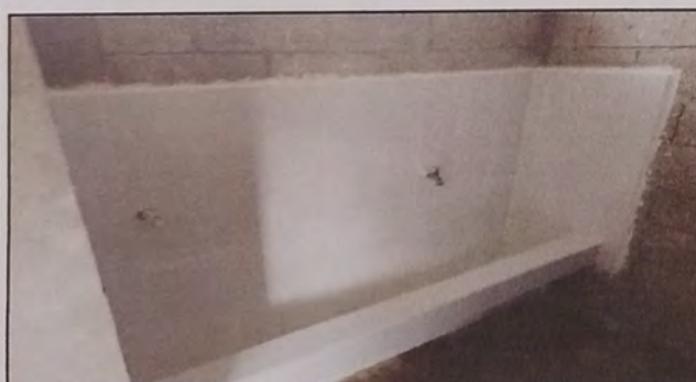
FOTO 11: SUSTITUCION DE AZUNEJO EN MIGITORIOS Y LAVAMANOS
