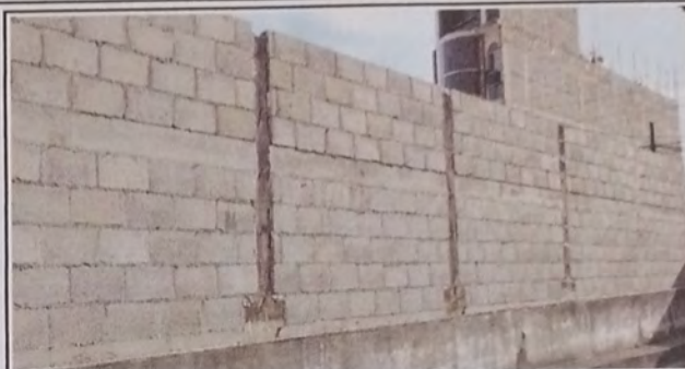
FOTO 8: MURO PERIMETRAL DE BLOCK
