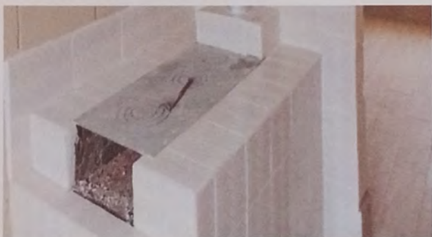
FOTO 3: SUSTITUCION DE PLANCHA DE METAL DE 3 HORNILLAS
