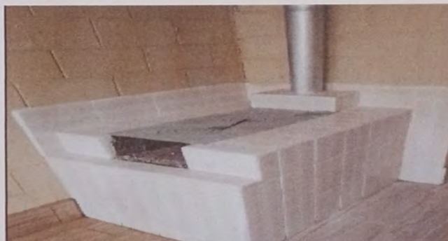
FOTO 4: INSTALACIÓN DE AZULEJO EN ESTUFA
