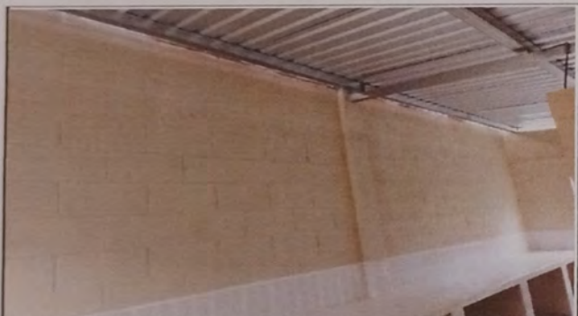
FOTO 9: PINTURA EN INTERIOR DE COCINA
