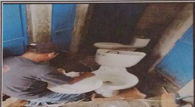
FOTO 10: SUSTITUCIÓN DE INODORO Y ACCESORIOS
