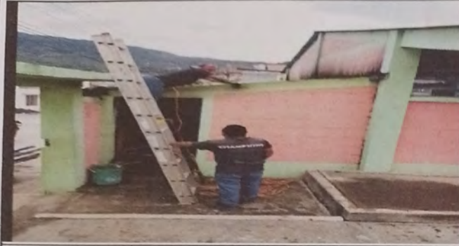
FOTO 1: SUSTITUCIÓN DE LAMINA POR LAMINA
