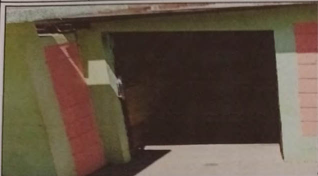
FOTO 7: SUSTITUCIÓN DE PUERTA DE METAL
