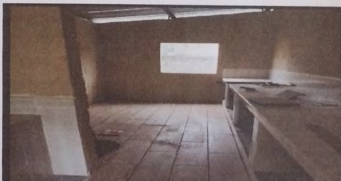
FOTO 6: INSTALACIÓN DE MESA EN COCINA
