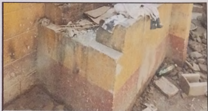
FOTO 4: INSTALACIÓN DE AZULEJO EN ESTUFA
