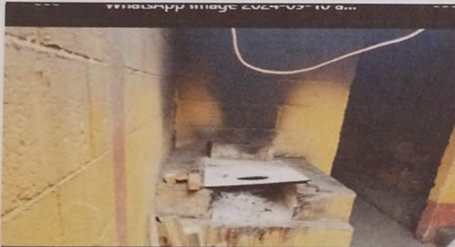
FOTO 3: SUSTITUCIÓN DE PLANCHA DE METAL DE 3 HORNILLAS
