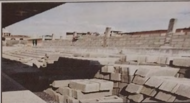
FOTO 8: MURO PERIMETRAL DE BLOCK
