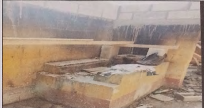
FOTO 2: SUSTITUCIÓN DE CHIMENENA DE METAL UNIDAD
