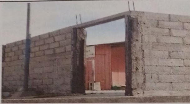
FOTO 13: SUSTITUCIÓN DE PUERTA
