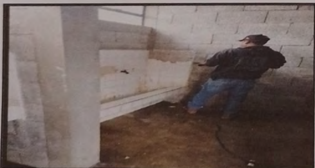
FOTO 11: SUSTITUCIÓN DE AZÚNEJO EN MIGITORIOS Y LAVAMANOS
