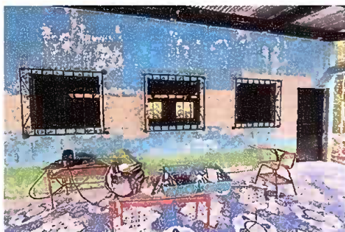
Foto 3, Módulo 1: Suministros e instalación de ventanas con balcón
