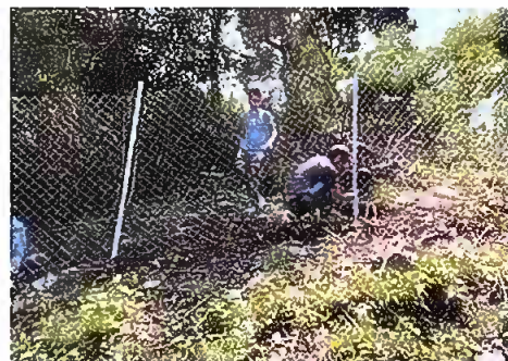
Foto 4, Reparación de muro perimetral de block con tubo hg y malla galvanizada, soleras intermedias y columnas.
