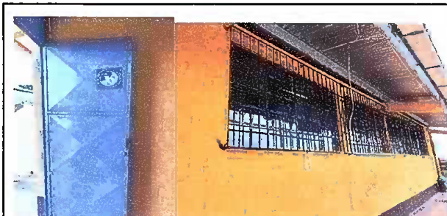
Foto 4: Modulo II: Mantenimiento de estructura de puertas de aula (lijado y pintado) suministro e instalación de balcones a aulas.
