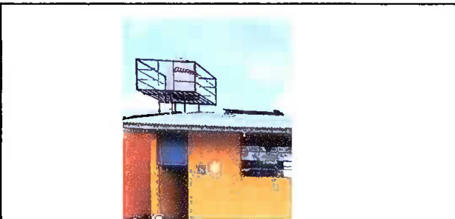
Foto 3: Modulo II: Sustitución de deposito de agua
