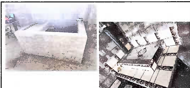
Foto7: Modulo III: Sustitucion de pila de cemento de un lavadero INSITU (1.20mts de largo por 1 metro de ancho). Instalacion de azulejo a estufa rural
