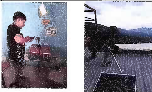
Foto 10: Modulo II: Sustitucion de panel solar 550 wts, inversor 3000 wts, baterias de 200 amp, regulador de 60 amp.
