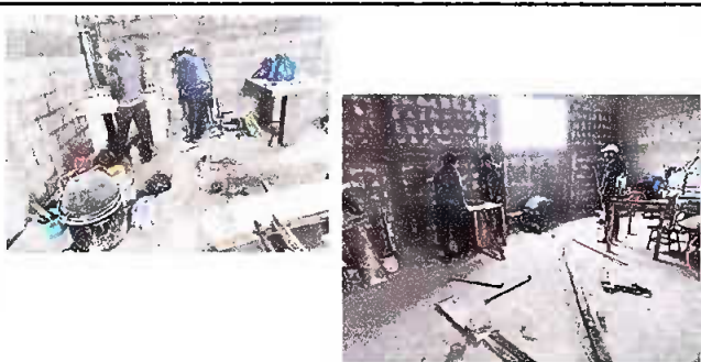
Foto7: Modulo III: Sustitucion de pila de cemento de un lavadero INSITU (1.20mts de largo por 1 metro de ancho). Instalacion de azulejo a estufa rural
