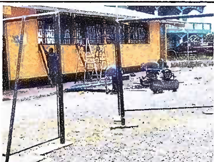
Foto 11: Modulo III. Suministro e instalacion de balcon de metal para concina
