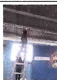
Foto 6: Modulo II: Sustitucion de focos ahorradores y reparacion de cableador electrico
