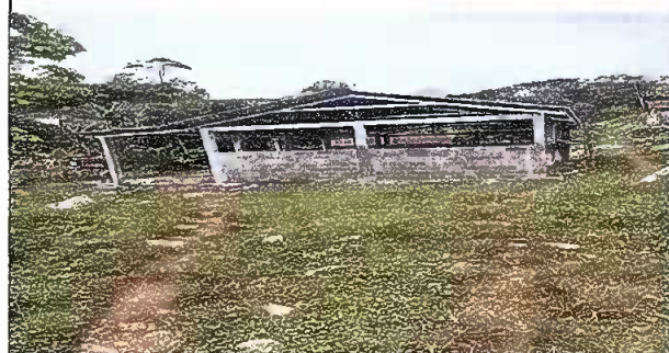
Foto 2. Modulo 1 reparación de muro de block
