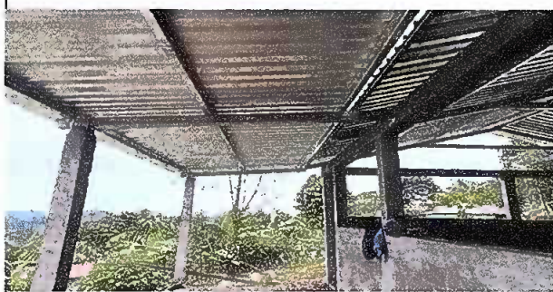
Foto No. 1. Modulo 1 Sustitución de lámina por lámina troquelada aluzinc calibre 26 y sustitución de estructura de soporte
