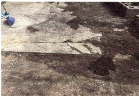
Foto 9: UN SECTOR DE LA CANCHA NO CUENTA CON TORTA DE CONCRETO Y OTRAS AREAS YA ESTAN DAÑADAS.
