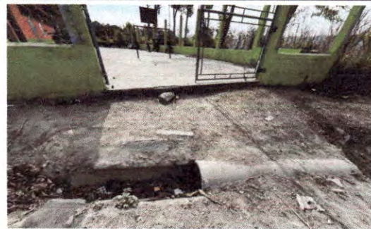
Foto 10: LA RAMPA DE ACCESO PRINCIPAL A LA ESCUELA NO CUENTA CON PISO DE CONCRETO.
