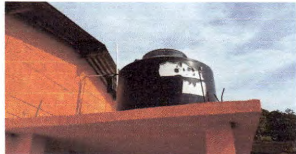
Foto 8: LA CAPACIDAD DEL DEPOSITO DE AGUA, ES MUY LIMITADA PARA EL ABASTECIMIENTO DE LA ESCUELA POR DIAS.
