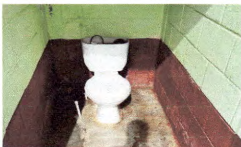
Foto 5: TANQUES DE INODOROS DAÑADOS Y SIN TAPADERAS.
