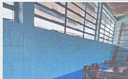
Foto 4: APLICACIÓN DE PINTURA INTERIOS EN AULAS
