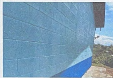
Foto 6: APLICACIÓN DE PINTURA EXTERIOR EN MODULO DE AULAS
