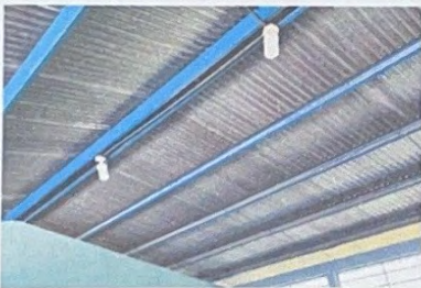
Foto 5: INSTALACION DE LUMINARIAS NUEVAS EN AULAS
