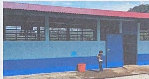
Foto 2: TRABAJOS DE MANTENIMIENTO DE PUERTAS Y VENTANAS DE AULAS
