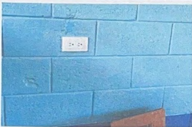
Foto 3: INSTALACION DE TOMACORRIENTES E INTERRUPTORES EN AULAS
