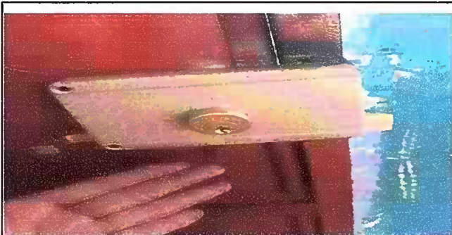
Foto 3: Sustitución de chapas
