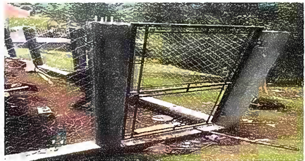
Foto 4: Colocación de puerta en el muro
