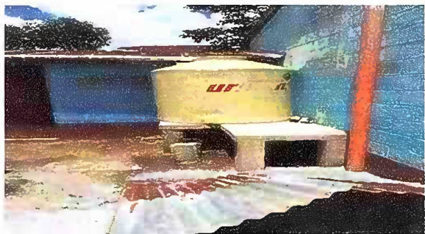
Foto1: sustitución de tinaco y caída de agua
