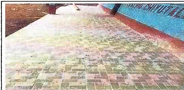
Foto 5: Sustitución de torta de concreto por piso cerámico
