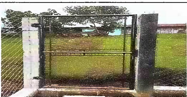
Foto 6: Reparación de muro perimetral
