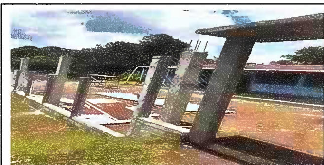
Foto 5: Reparación de muro perimetral
