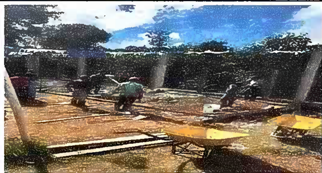
Foto1Foto 9: Sustitución de torta de piso por cemento líquido
