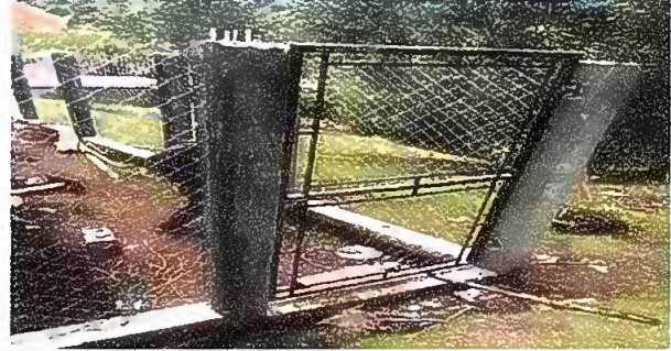
Foto 4: Colocación de puerta en el muro
