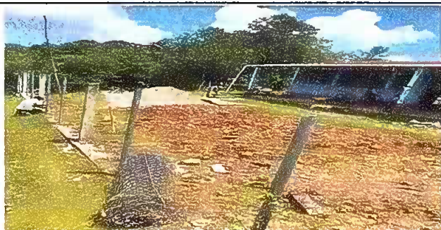
Foto 5: Reparación de muro perimetral
