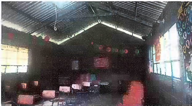
Módulo I: Foto1: sustitución de lámina por laminatroquelada calibre 26 allicinc, capotes, estructura de metal y tornillos.
