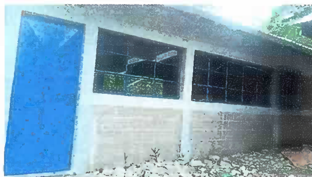
Módulo I: Foto 2: sustitución de puerta de metal
