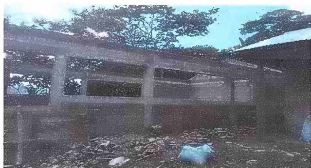
Módulo I: Foto 3: se mejoro las talladas de todas las soleras y columnas
