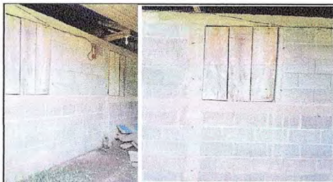
MODULO 1. FOTO 3 Sustitucion de ventana de metal mas vidrio con Valcon
