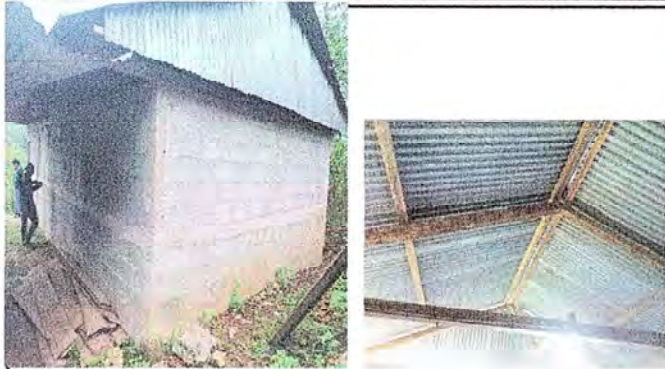
MODULO 1. Foto No. 1 y 2 Sustitucion de lamina, por lamina troqueladaa luzinc calibre 26 Sustitucion de capote de lamina para lamina troquelada
