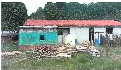
Foto No.3. Modulo II. Reparación de muro perimetral de block (aulas), sustitución de piso de torta de concreto.
