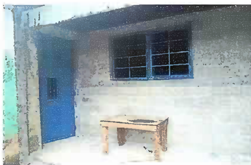
Foto 4: Modulo II. Sustitución de puertas y sustitución de ventanas de madera por metal más vidrio.
