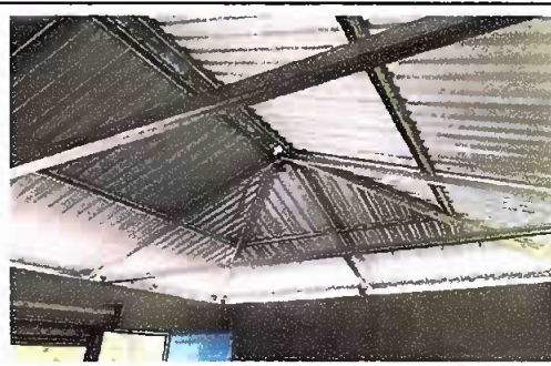
Foto 4, Cocina: Sustitución de lámina por lámina troquelada aluzinc calibre 26
