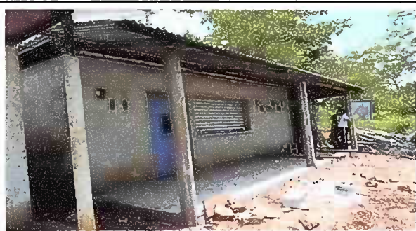
Foto 3, Cocina: Levantado de pared (incluye soleras y columnas)
